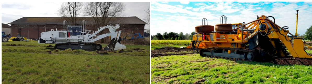
Figur 5 och 6. Barthollandrain.nl, Självgående täckdikningsplog och kedjegrävare
